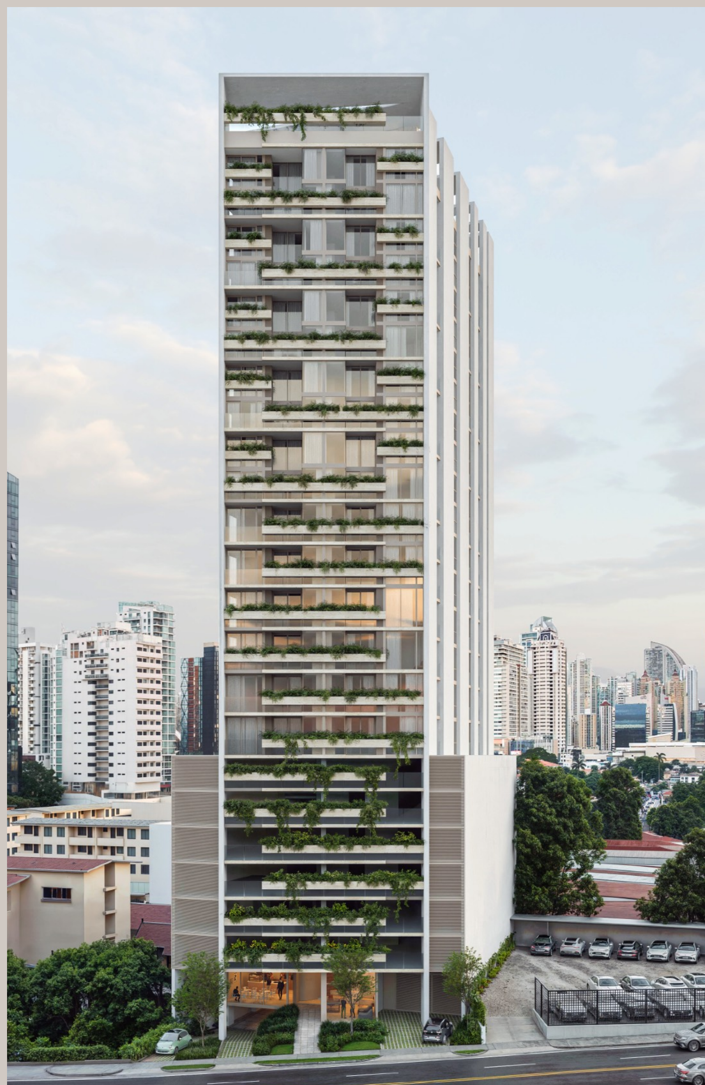
65 Vía Porras / San Francisco
